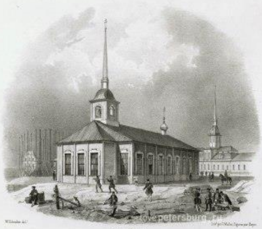
VUE DE LA PREMIERE EGLISE DE SAINT-ISAAC BÂTIE EN BOIS EN 1750.
